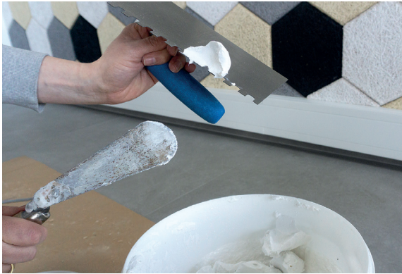
1: Påfør en lille mængde FibroTech Montage- lim på spartel eller lign. værktøj.
