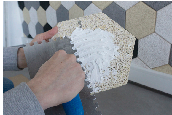
2: Fordel med spartel eller lign. FibroTech Montage- lim på den enkelte hexagon.
